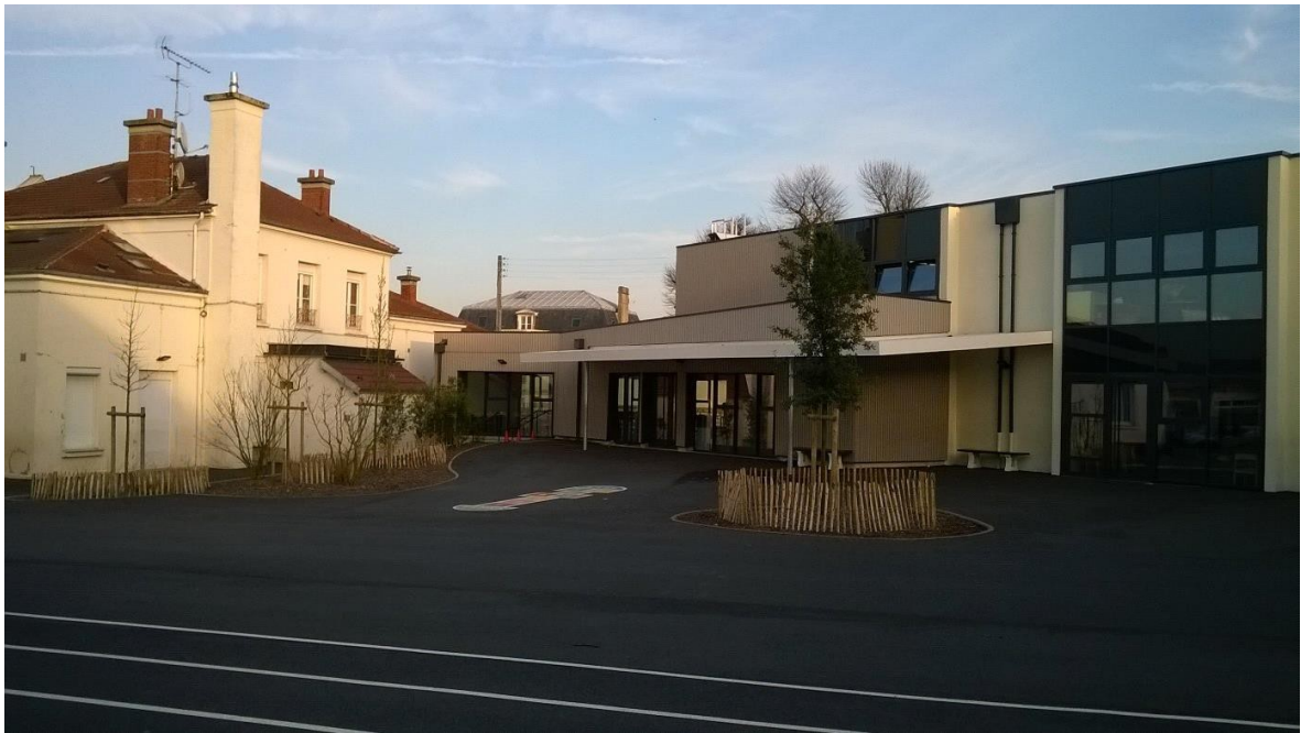
C'est la nouvelle cantine du bâtiment moderne. Elle a été agrandie en 2016.
